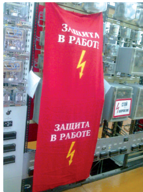
ШТОРКИ ДЛЯ ОГРАЖДЕНИЯ ПАНЕЛЕЙ РЗА 1000X2500 НА ТКАНЕВОЙ ОСНОВЕ «ЗАЩИТА В РАБОТЕ»
